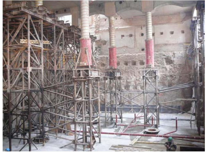
Dočasné založení nových železobetonových sloupů na mikropilotových bárkách v jižním křídle budovy, veškeré původní vnitřní nosné stěny jsou již vybourány.
