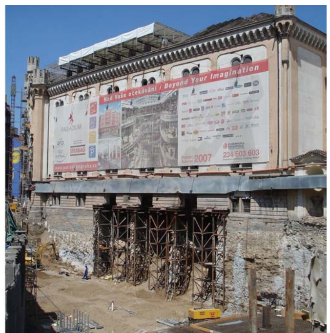
Pohled z Náměstí Republiky na podchyčenou průčelní fasádu v době výkopu pro zbudování přístupu ke stanici metra.
