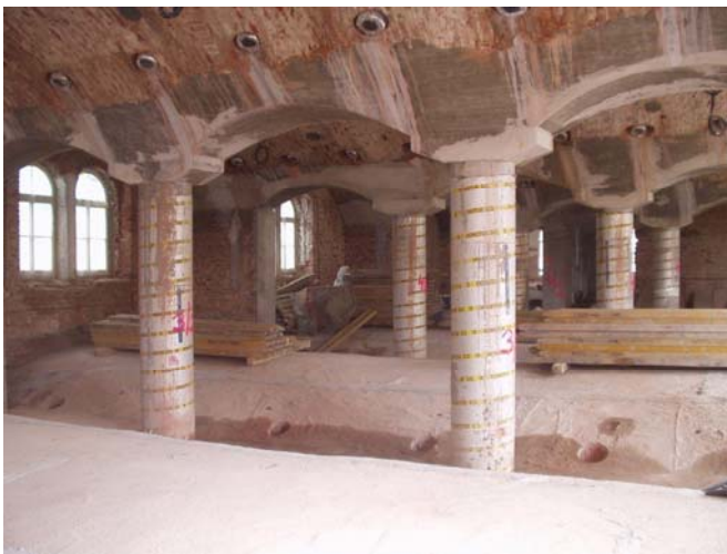
Nová železobetonová konstrukce převzala podepření původních stropních klenb. Veškeré původní vnitřní nosné stěny jsou již vybourány. Pohled je v jižním křídle ve 3.NP.
