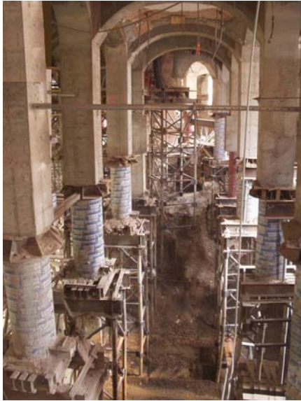
Dočasné založení nových železobetonových sloupů na mikropilotových bářkách ve střední části budovy, veškeré původní vnitřní nosné stěny jsou již vybourány.
